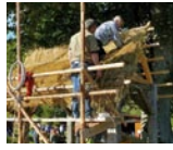
22 Dach degge Dach eindecken
